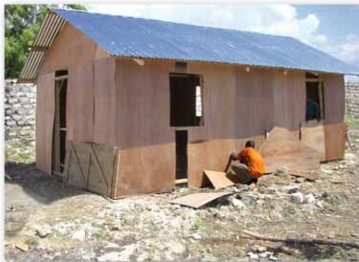
Das Übergangs-Kindergartenhaus aus Holz und Wellblech
