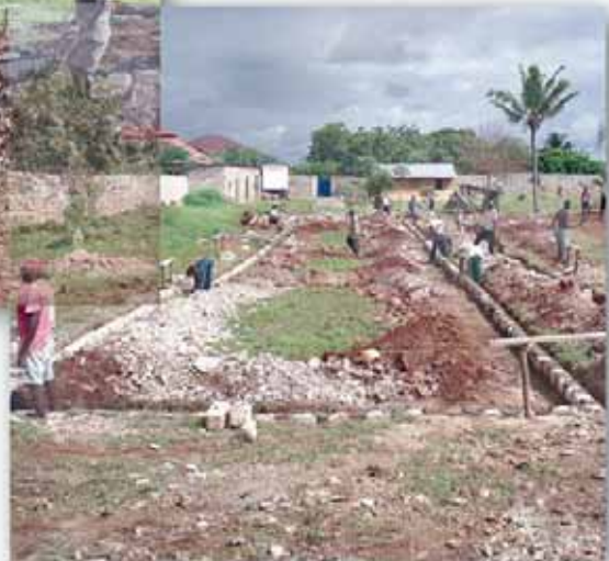
...denn die Grundmauern sind schon zu erkennen.
