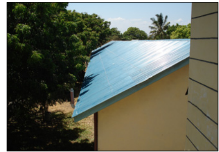
Auch die verrosteten Dächer, die mittlerweile undicht waren, haben wir erneuert. Unschwer zu erkennen, links die alte - und rechts die neue Dachabdeckung.
