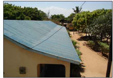
Auch die verrosteten Dächer, die mittlerweile undicht waren, haben wir erneuert. Unschwer zu erkennen, links die alte - und rechts die neue Dachabdeckung.
