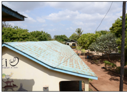
Auch die verrosteten Dächer, die mittlerweile undicht waren, haben wir erneuert. Unschwer zu erkennen, links die alte - und rechts die neue Dachabdeckung.
