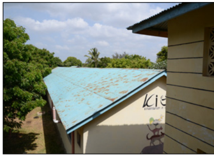
Auch die verrosteten Dächer, die mittlerweile undicht waren, haben wir erneuert. Unschwer zu erkennen, links die alte - und rechts die neue Dachabdeckung.
