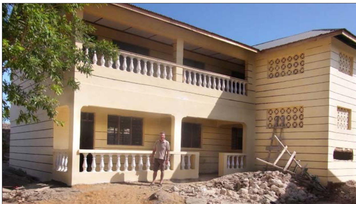
Das neue KiD-Schulgebäude - Manfred Linder bei der Rohbau-Abnahme.
