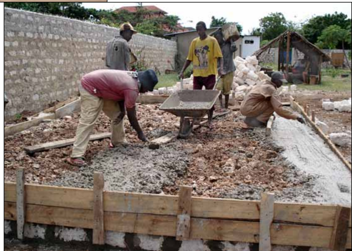
Hier entsteht das Toilettengebäude für die Kleinen. Im Hintergrund (rechts) sieht man eine Makutihütte, die wir zur Zeit noch als „Office“ nutzen.
